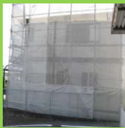
②ネット養生
