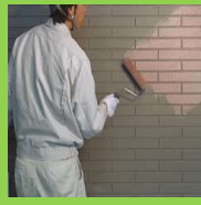
④外壁塗装
