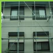
①足場設置
